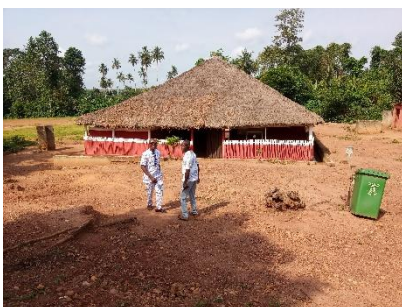
Krankenstation Sampa außen
